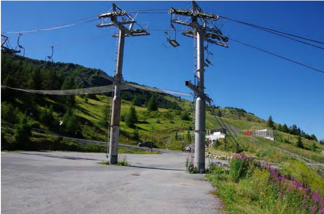
Photo 43 Perception proche frontale peu valorisante des poteaux sur le parking
