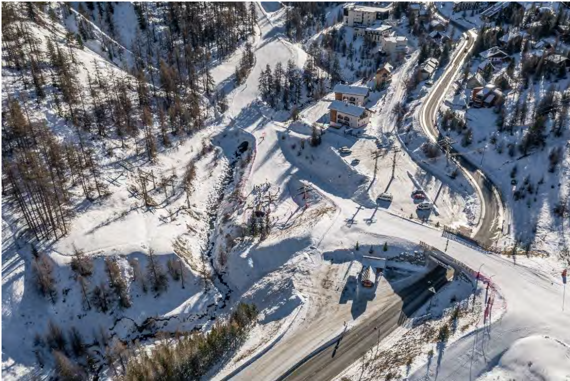
Photo 40 Vue aérienne de l'articulation du secteur avec la route, la piste en passage supérieur et l'entaille du torrent
