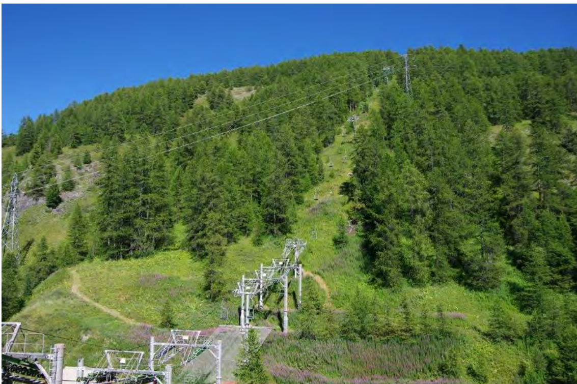
Photo 34 La limite de l'entité en bas du boisement : passage du layon du TS Peynier et du réseau électrique
