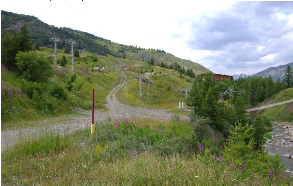
Photo 39 un couvert prairial en pente, traversé par le télésiège de Peynier perceptible par ses poteaux, à droite le torrent
