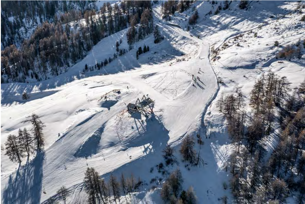
Aménagement actuel de la gare amont
