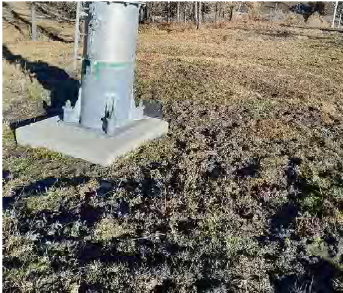
Figure 10 : pylône P8 actuel
