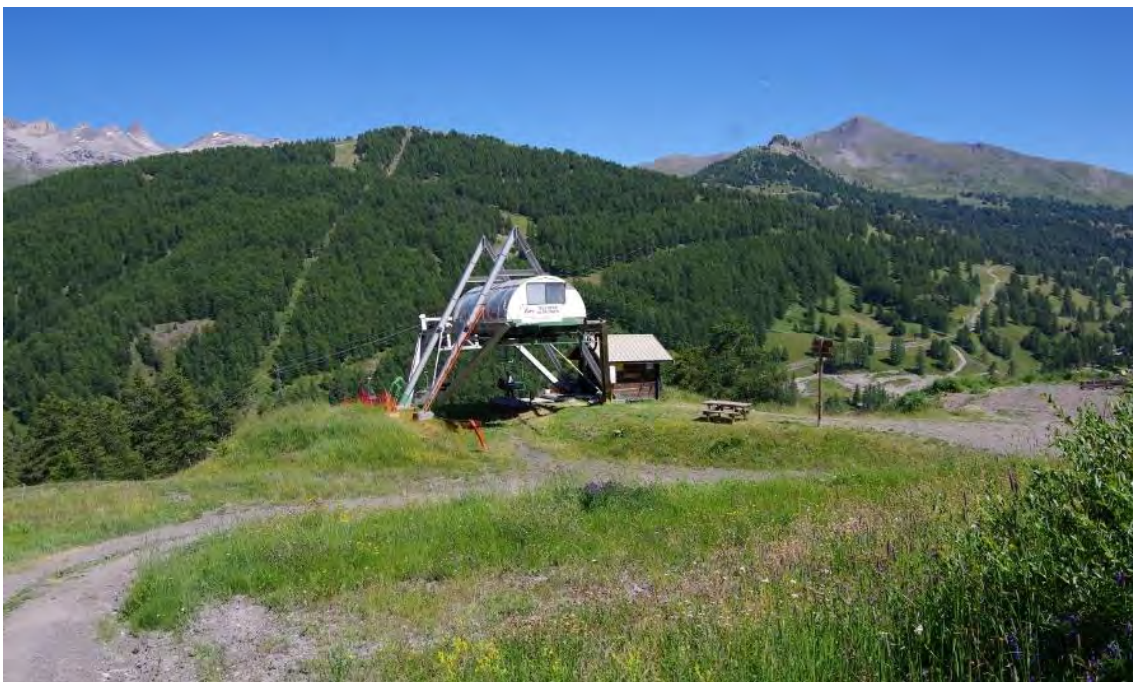
Photo 48 Les plateformes terrassées du TS Peynier forment un promontoire anguleux dans la pente
