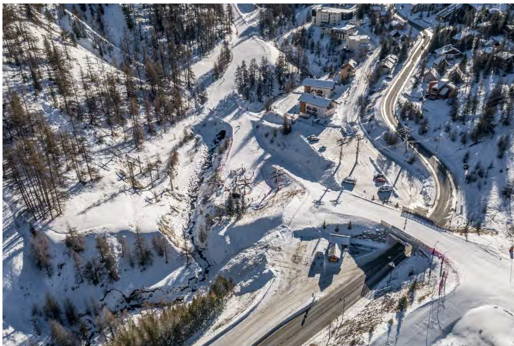
Aménagement actuel de la gare aval
