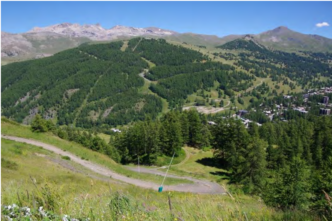
Photo 30 Un boisement de mélèzes marqué par les coupes franches engendrées par les pistes, les layons et le passage du réseau électrique aérien
