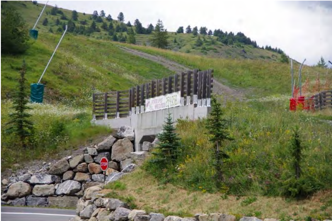
Photo 44 Des enrochements du passage supérieur très perceptibles et qui contrastent dans ce couvert prairial
