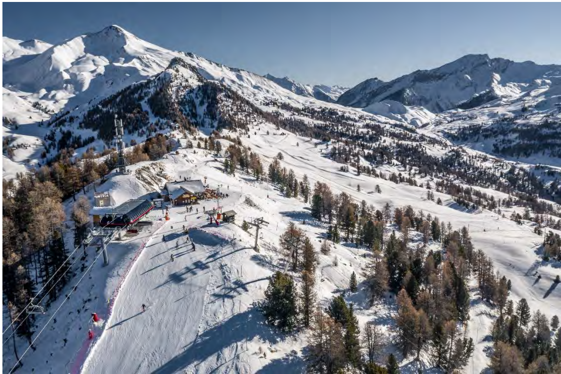
Aménagement actuel de la gare amont
