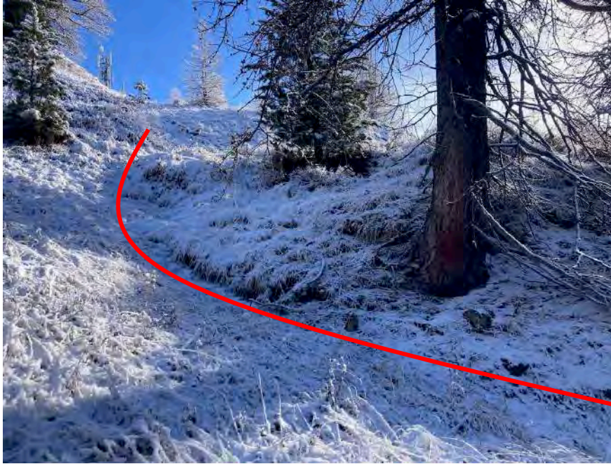
Figure 10 : Bourrelet de glissement en base des remblais
