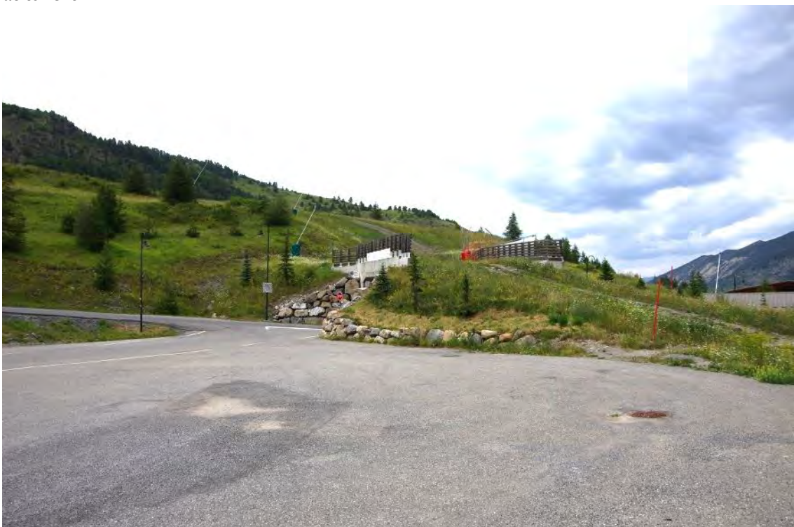
Photo 41 Un des parkings, au droit du passage supérieur de la piste. Les enrochements sont très visibles
