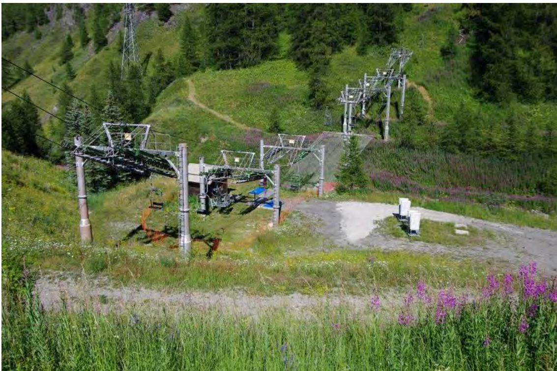
Photo 42 La jonction entre les 2 versants, sans fond de vallée, la présence des nombreuses émergences verticales avec les poteaux de la remontée
